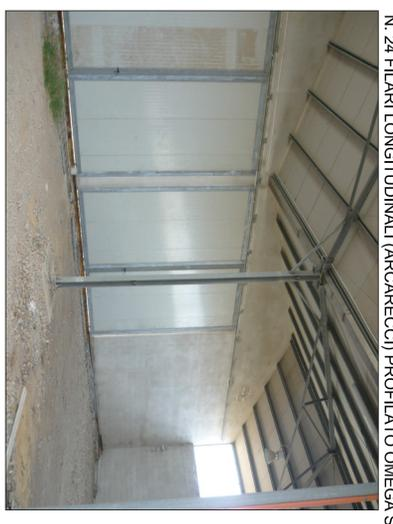
N. 24 FILARI LONGITUDINALI (ARCARRECCI) PROFILATO OMEGA SEZ. 100X50X30X3
