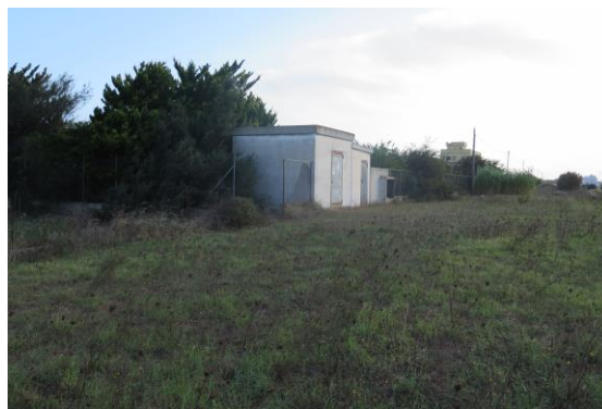
Panoramica UR 4. Veduta da sud ovest.
