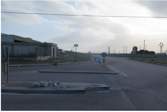
Panoramica UR 2. Veduta da sud ovest.
