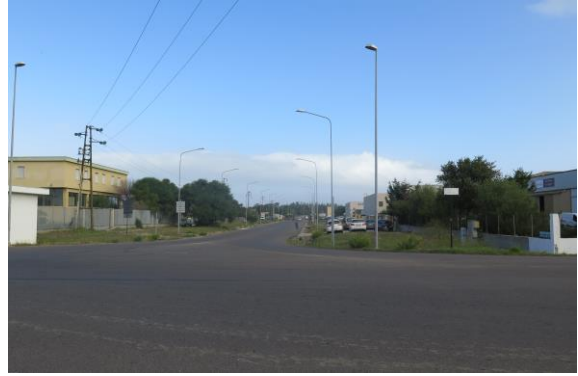
Panoramica UR 6. Veduta da sud ovest.
