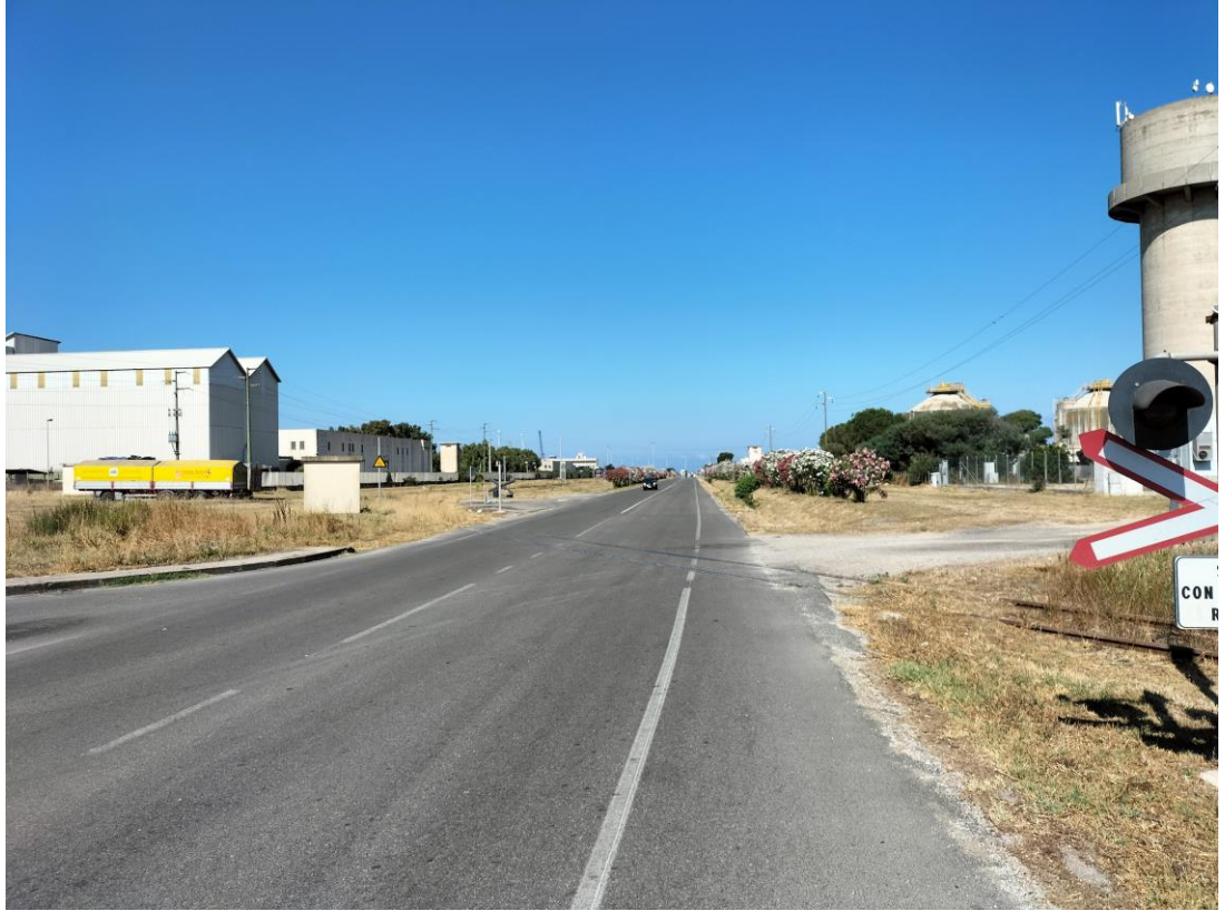
Vista 5 – Via Marongiu – Pre intervento
