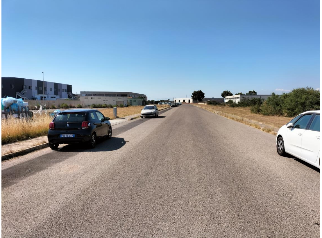
Vista 4 – Via La Maddalena – Pre intervento
