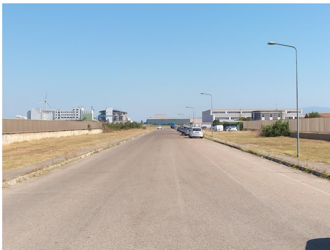
Vista 3 – Via La Maddalena – Post intervento
