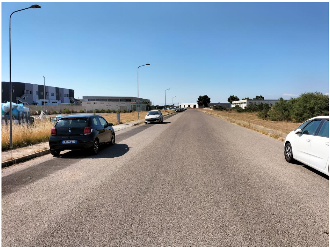
Vista 4 – Via La Maddalena – Post intervento
