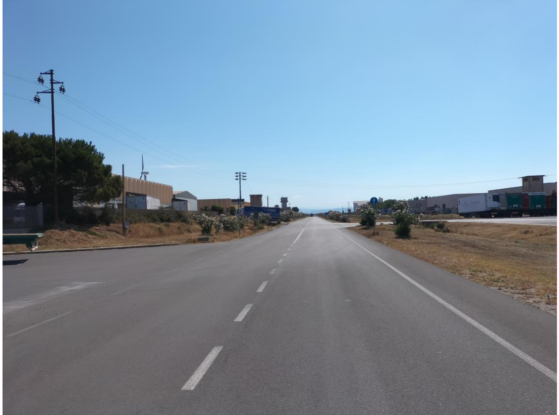
Vista 6 – Via Marongiu – Pre intervento
