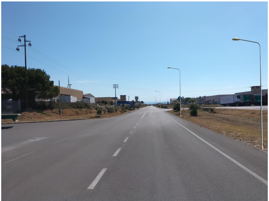
Vista 6 – Via Marongiu – Post intervento
