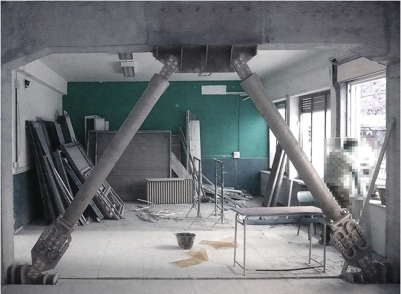
Installazione di controventi dissipativi
