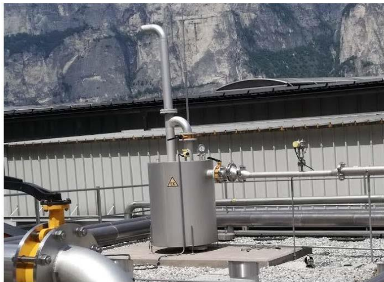
Figura 14 - VISTA FOTOGRAFICA DELLA "GUARDIA IDRAULICA TIPO"
